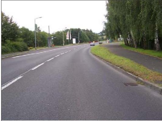
Der aus Richtung Norden (von der A 71) kommende Fahrzeugführer kann bei Annäherung in der Krümme die Situation der Einmündung erst recht spät erkennen.
