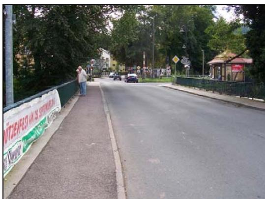
Der Brückenquerschnitt mit 6,65 m zwischen den Borden zzgl. beidseitig 1,65 m Gehbahn (lichte Weite zwischen den Brückengeländern ca. 9,95 m) lässt keinen Regelquerschnitt mit angemessener Berücksichtigung des Radverkehrs zu. Als Planungsansatz muss langfristig bei Ersatz/Sanierung der Brücke eine angepasste Dimensionierung umgesetzt werden.
