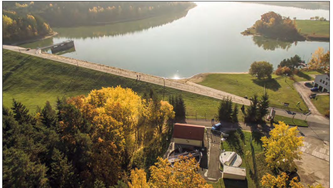
Blick auf die Kläranlage des Zweckverbands Wasser- und Abwasser-Verband Ilmenau (kurz: WAVI) im Ortsteil Heyda Foto: WAVI
