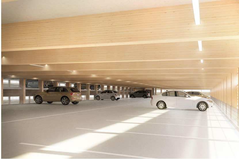
Innenansicht der Tragkonstruktion mit Baubuche der Firma Pollmeier Creuzburg
