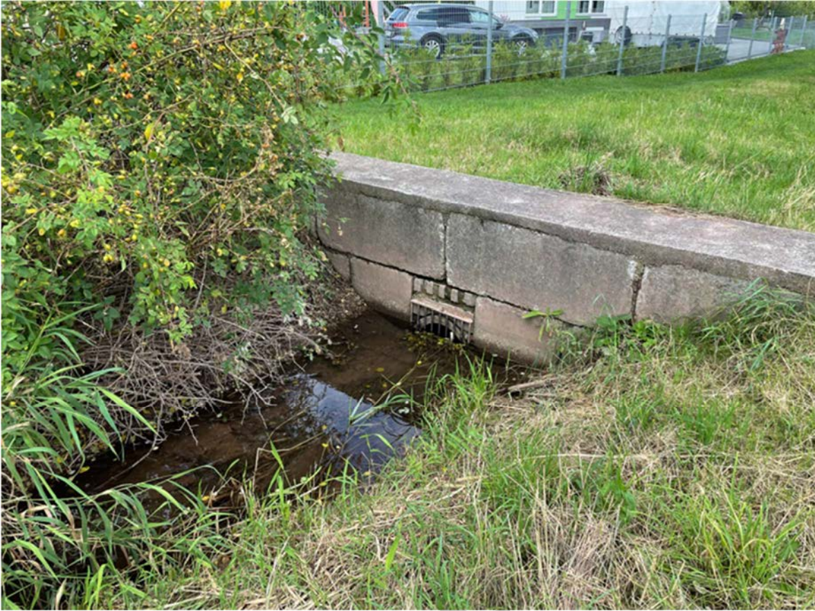
Schobsewehrgraben – Beginn der Verrohrung (Foto: isu)
