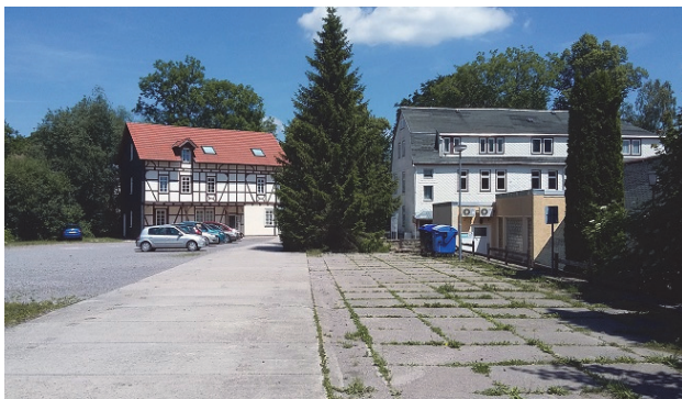
Blick Richtung Kontorhaus
