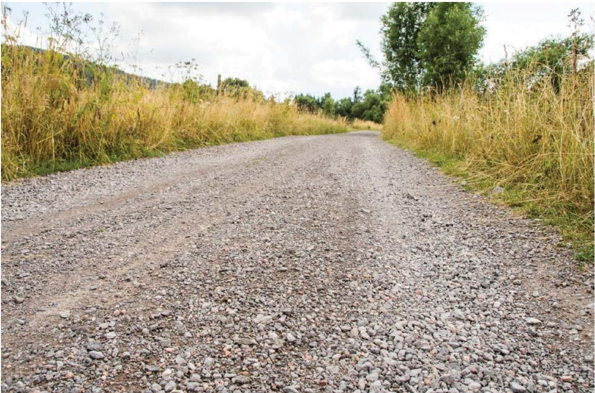
*Abbildung 14: Vergrößerung der Schotterauflage (II)*
