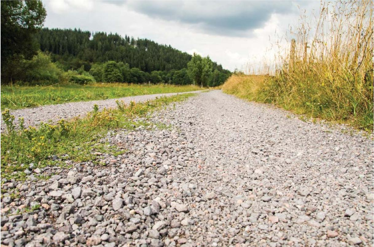
*Abbildung 13: Vergrößerung der Schotterauflage (I)*
