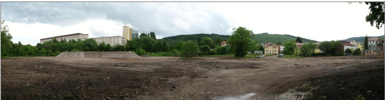
Blick nach Süden, links der gebietsbegrenzende Bahndamm (eigene Aufnahme, Juni 2012)
