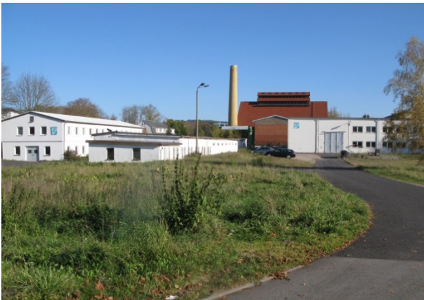
Gewerbliche Gebäude mit Blick nach Osten in Richtung Fischerhütte (eigene Aufnahme, Oktober 2014)
