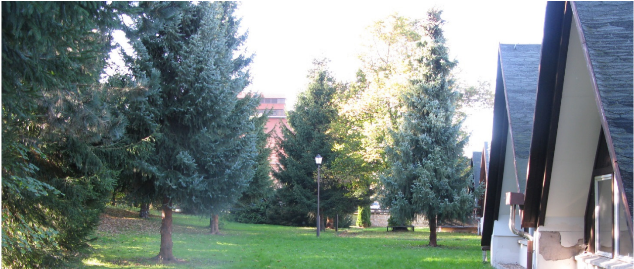
Blick nach Westen, im rückwärtigen Bereich der Finnenhütten (eigene Aufnahme, Oktober 2014)
