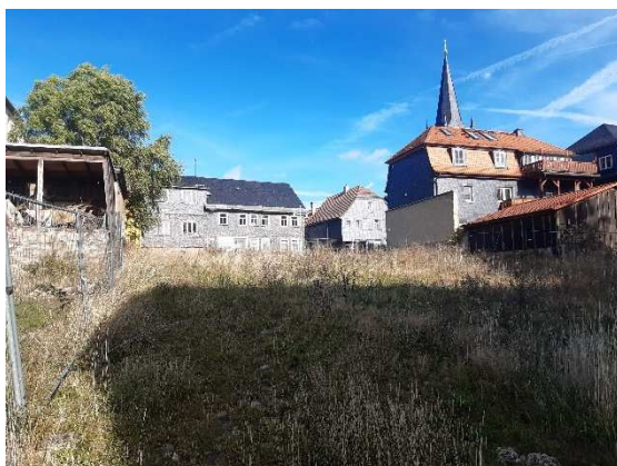
Abb. 3: Blick von „Kirchberg“ in Richtung Obere Marktstraße auf das historische Rathaus/ Kirche
