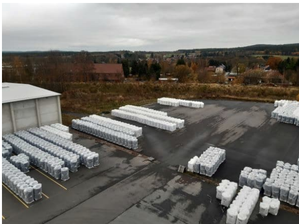
Abb. 9 und 10 Zustand der Lager- und Ruderalflächen
