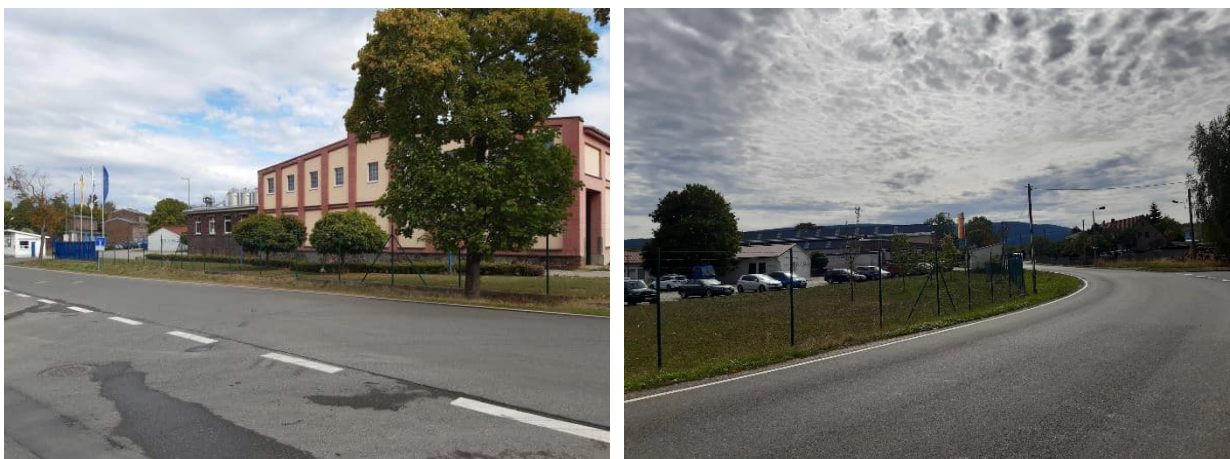
Abb.3 und Abb.4 Ansicht aus Richtung Arnstädter Straße mit Blick zum Haupteingang CFF Gehren
