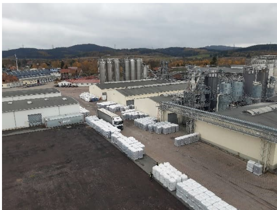
Abb. 1: Blick über Betriebsgelände in Richtung Südosten
