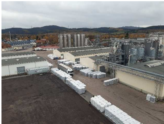
Abb. 1: Blick über Betriebsgelände in Richtung Südosten
