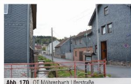
Abb. 170 OT Möhrenbach Uferstraße
