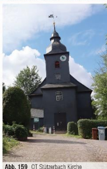
Abb. 159 QT Stützerbach Kirche
