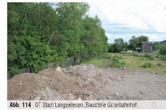
Abb. 114 OT Stadt Langewiesen, Baustelle Güterbahnhof
