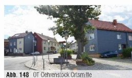
Abb. 148 OT Cehrenstock Ortsmitte
