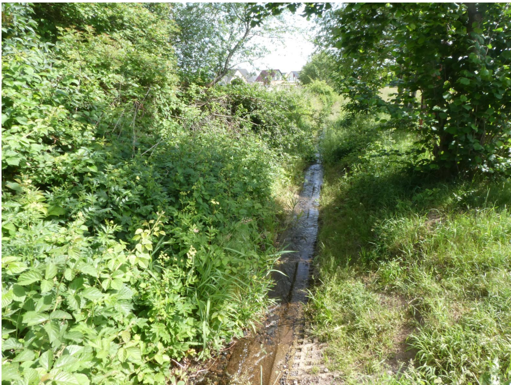
Abb. 5: Ausgebauter Graben im südlichen Teil des Planungsraumes am Feldgehölz (14. Juni 2022; Foto: J. Weipert)
