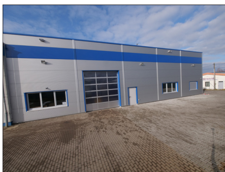
Neubau der Firmenhalle
