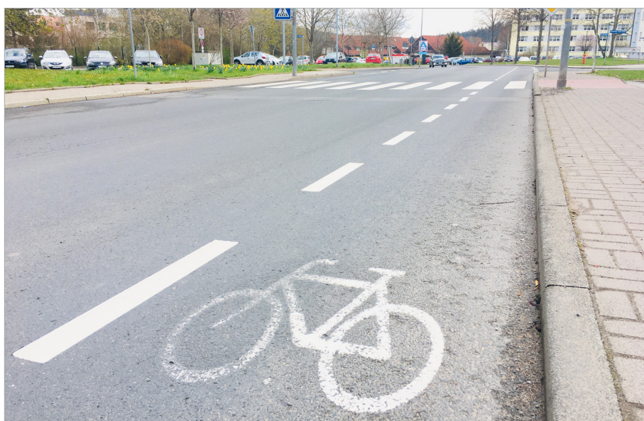
Schutzstreifen in der Johann-Friedrich-Böttger-Straße
