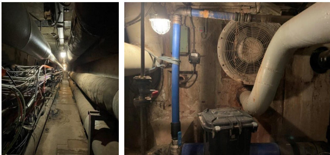
Abbildung 35: links: Blick entlang eines Sammelkanals. rechts: Endpunkt bzw. Hausübergabestelle mit Gebläse
