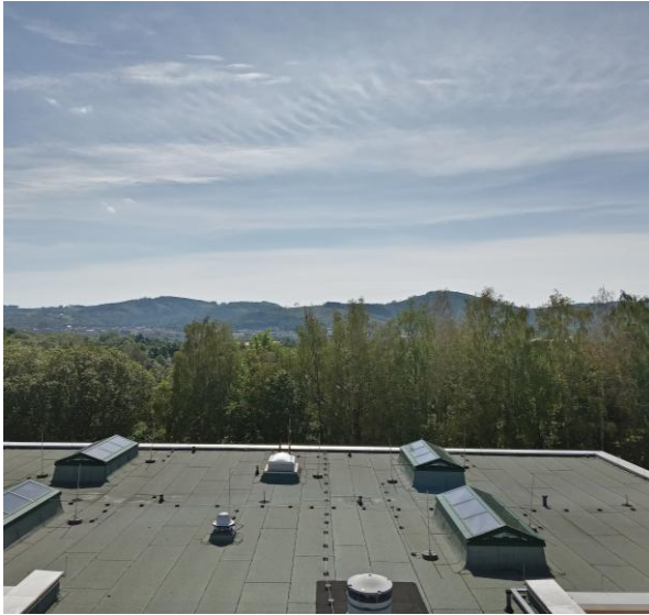
Dach des Anbaus
