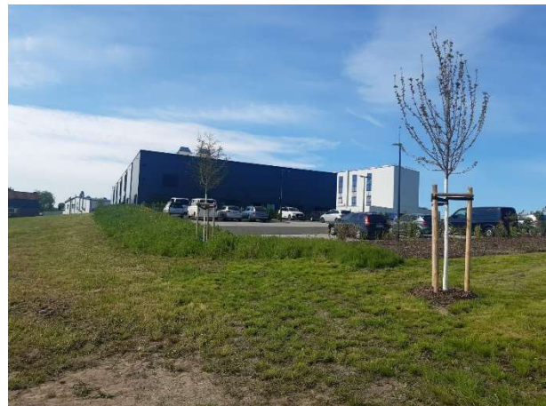
Abb. 4 angrenzender bebauter Teil
