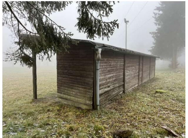
Unterstand im Nordwesten des Plangebiets, Quelle: Stadtverwaltung Ilmenau
